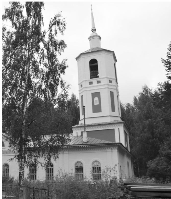
Колокольня Введенского храма после ремонта
