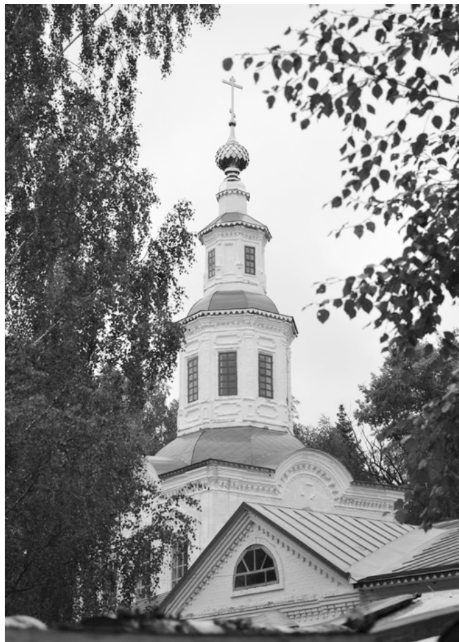
Введенский храм после ремонта.
